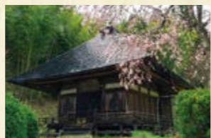
⑪富田薬師堂《鮫川村》 堂内に木造薬師如来立像と金剛力士立像が安置されている。
